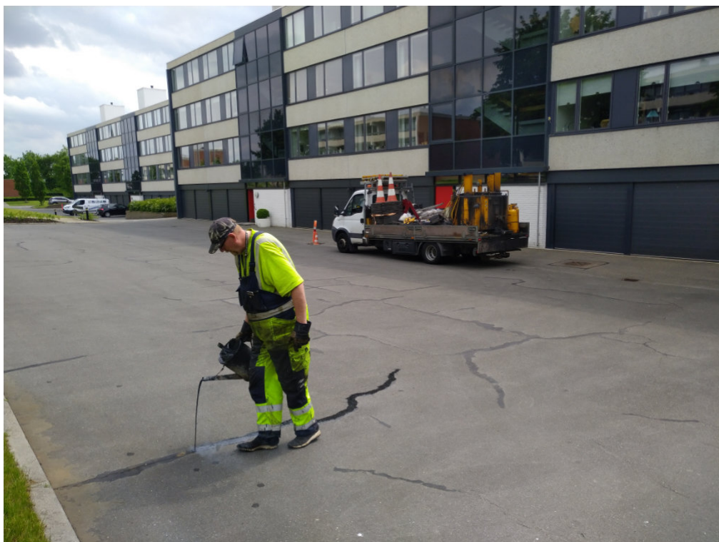
I juni 2020 rykkede et asfaltsjak ind i Præste-haven og reparerede de mange revner og huller, der med tiden var opstået i asfalten på parkeringspladserne.
