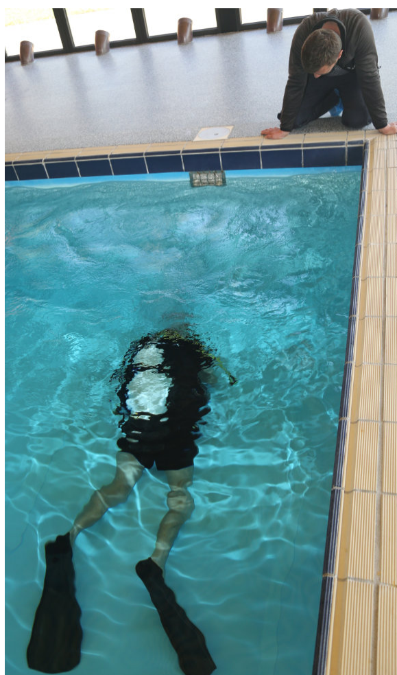
Eigil Nielsen, Blok 20, dykkede ned for at montere en rist. Foto: Peter Jessen.
