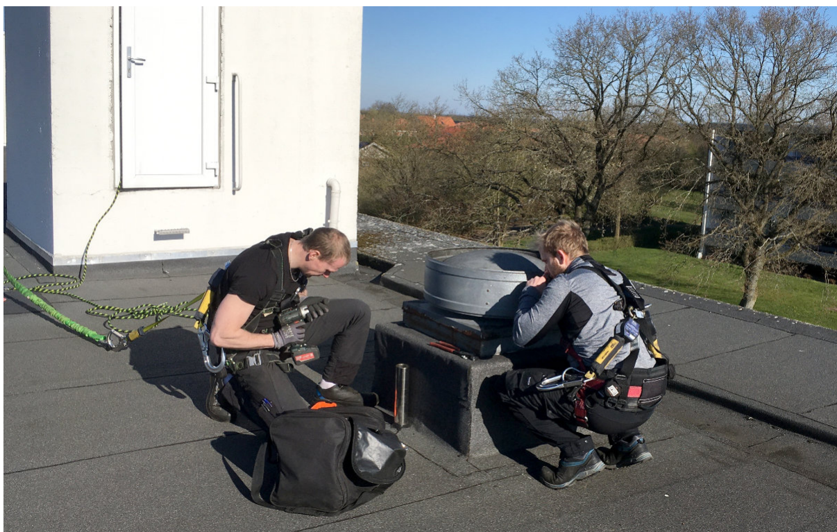
To mand fra Pronor IndustriTeknik på taget for at tjekke »hætter«. Foto: Ingrid M. Schmidt
