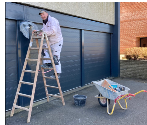
Ernst fra murerfirmaet Viggo Søby A/S i gang med fugearbejde i Præstehaven.
