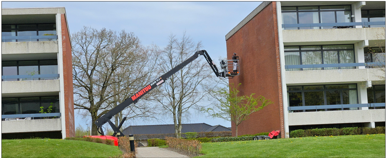
I 2024 afsluttede vi projektet med renovering af alle gavle. Arbejdet krævede en lift, som det ses. På billedet er Viggo Søbys opsendte nået til Blok 10.
