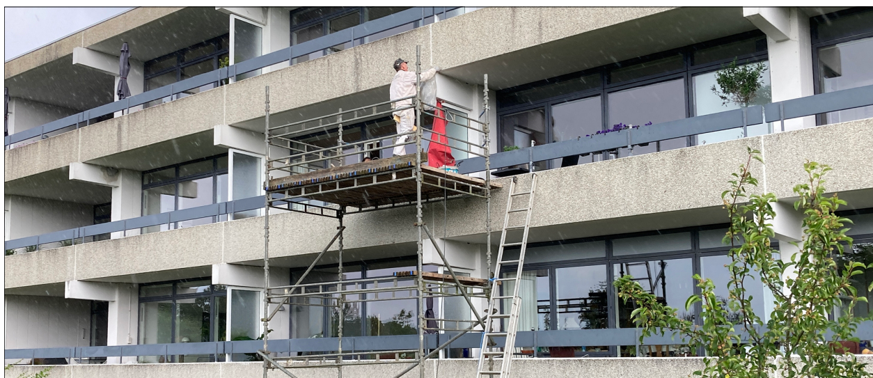
Ernst fra murerfirmaet Viggo Søby udbedrer en gammel skade på betonen på Blok 20.
