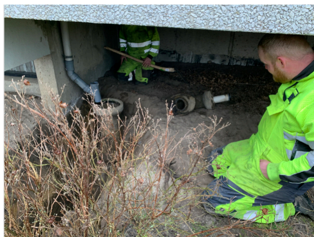
En ny flexbrønd bliver monteret ved Blok 16.
